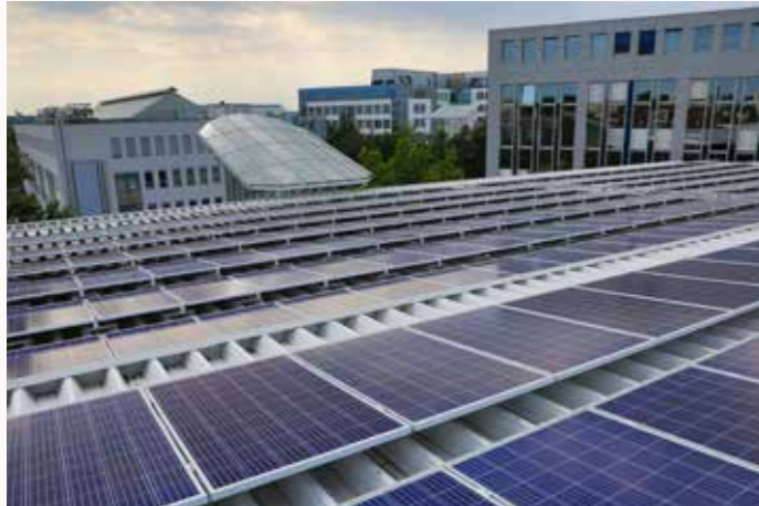
Die nachhaltigen Gebäudekonzepte sind mit modernster Technik ausgestattet. Die Ladesäulen für Elektroautos in den Parkhäusern werden von einer Photovoltaikanlage auf dem Dach gespeist.
